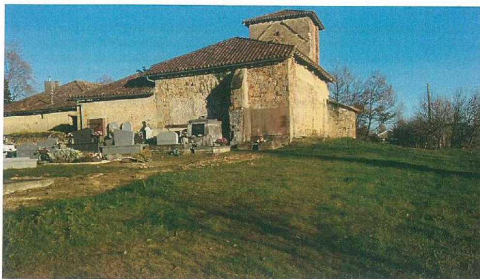
L'église d'Espagnet après travaux
